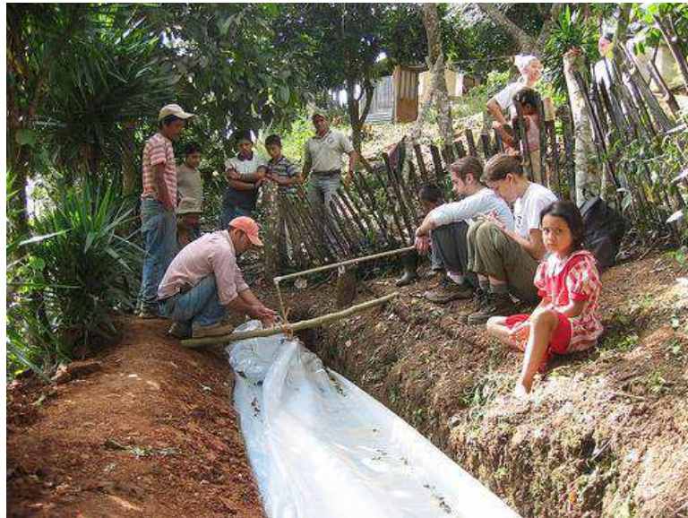
Şekil: Torba Tipi (Tayvan-Çin) Reaktörler
