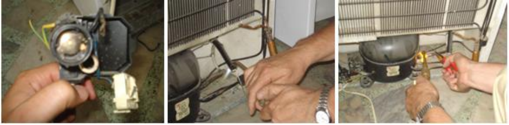
Resim 6.5: Kompresörün evaporatör dönüş boru bağlantılarının kaynakla ayrılması
