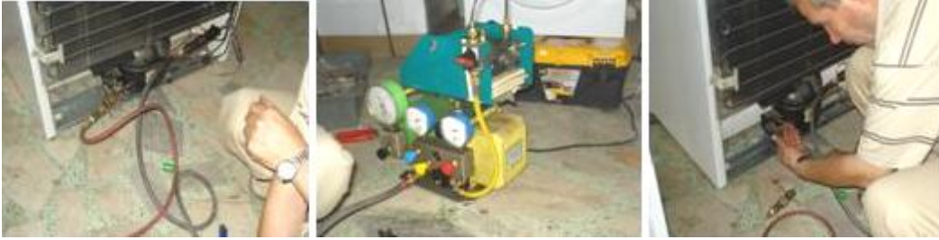
Resim 2.5: Vakum cihazının çalıştırılması ve vakum kontrolünün yapılması
