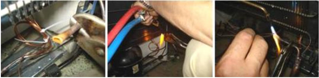
Resim 2.13: Kompresör servis borusuna pinçof yardımı ile oksijen kaynağı yapılması (drayer vakum ucuna yapıldığı gibi)
