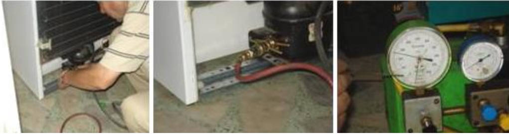
Resim 2.6: Vakumlama işleminin başlaması ve vakum göstergesinin gözlenmesi
