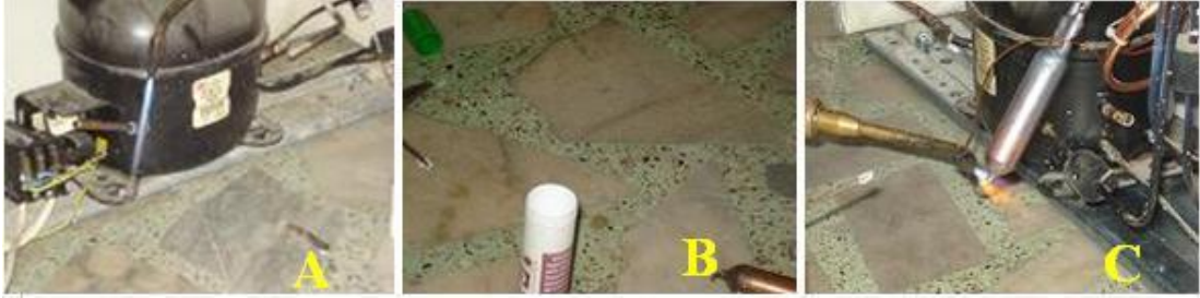
Resim 4.3: A) Kaynak yapılacak yerin ısıtılması ve kor şekline dönüşmesi B) Gümüş telin boraksa batırılması C) Gümüş telin ısıtılan kaynak yerine dokundurulması
