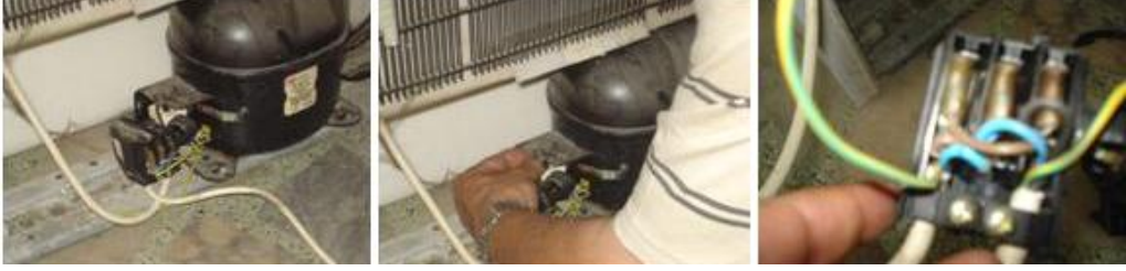
Resim 6.4: Kompresör elektrik bağlantısının (termik rölenin) sökülmesi
