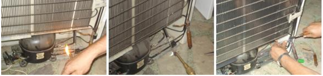
Resim 5.3: Kondanserin kompresör ve drayerden kaynak yardımı ile ayrıştırılması
