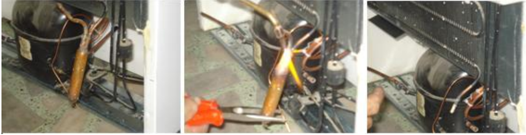
Resim 5.7: Drayerin yerinden sökülmesi
