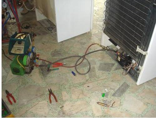
Resim 2.2: Vakum cihazının soğutma sistemine bağlantısı
