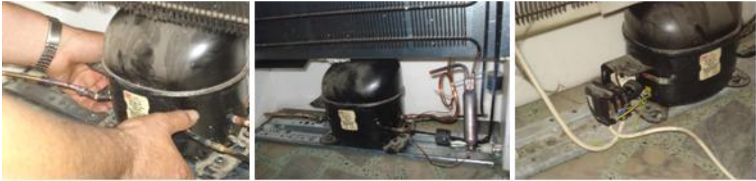
Resim 6.7: Kompresörün sökülmesi, yeni kompresörün takılması ve vidalanması, bağlantı borularının söküldüğü gibi kaynakla birleştirilmesi ve elektrik bağlantılarının yapılması
