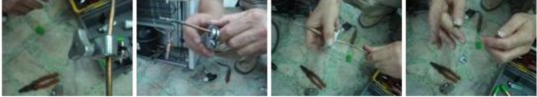
Resim 4.6: Bakır boru kesme makası ile bakır boru kesme işlemi
