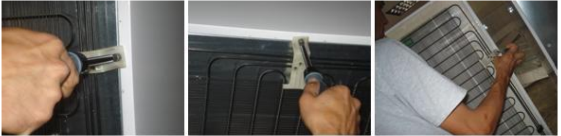
Resim 5.4: Kondanserin dolaba bağlantı vidalarının sökülerek dolaptan ayrılması
