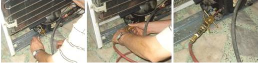
Resim 2.4: Kompresör servis borusuna T adaptör ile vakum cihaz hortumunun bağlanması
