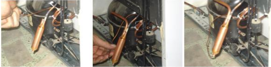
Resim 5.8: Drayerin yerinden sökülmesi ve yeni drayerin takılması
