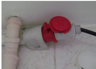
Resim 1.30: Elektrik bağlantı prizi ve fişi
