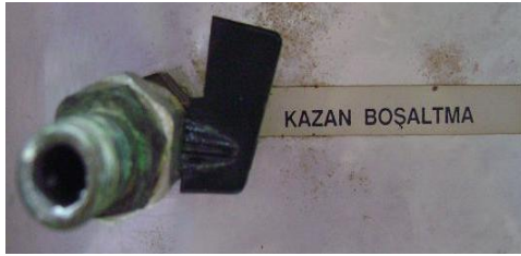
Resim 1.23: Kazan boşaltma çıkışı
