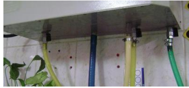
Resim 1.29: Su tesisat bağlantıları tamamen bitmiş çalışmaya hazır cihaz
