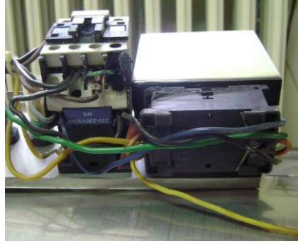
Resim 3.12 Su seviye kontrol ünitesi montaj alanı
