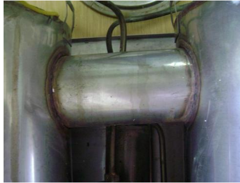
Resim 5.5: Buhar geçiş kanalı
