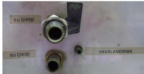
Resim 1.25: Şehir şebeke su giriş ve çıkışı, havalandırma girişi
