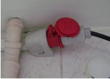
Resim 1.14: Trifaze bağlantı prizi ve fişi
