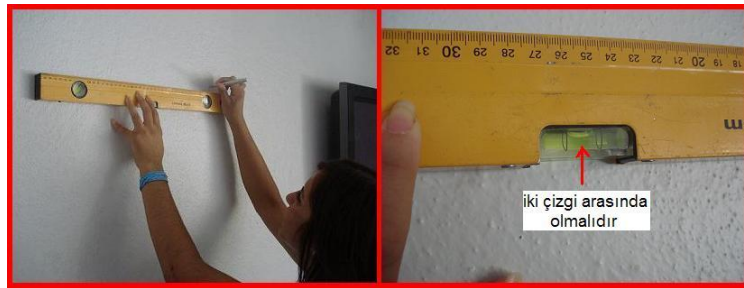
Resim 1.19: Delik yerlerini işaretleme ve dengeye getirme
