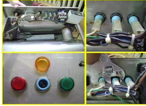
Resim 3.8: Uyarı lambalarının sökülmesi
