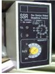
Resim 1.6 :Su seviye ve kazan boş ünitesi
